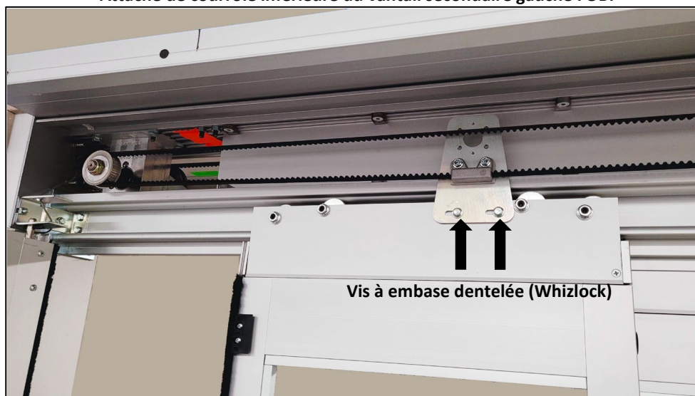
Figure 38 Installez le chariot du vantail secondaire sur le rail.
